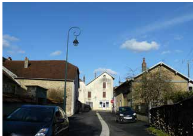
Chaussée mixte en enrobé et caniveau en béton
