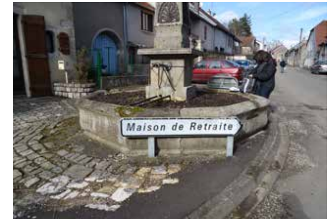
Pavage calcaire sous de l'enrobé
