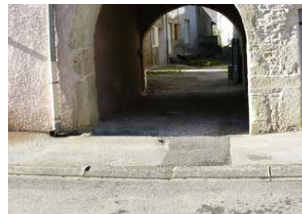
Trottoir en enrobé et bordure A2 en béton
