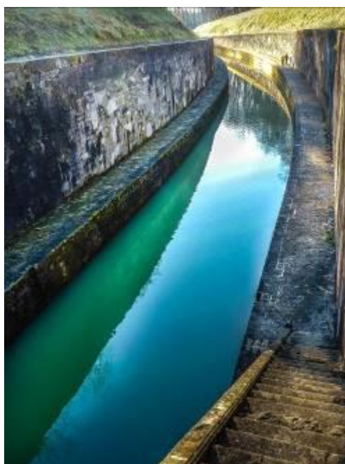
Le tunnel de Saint Albin côté aval
