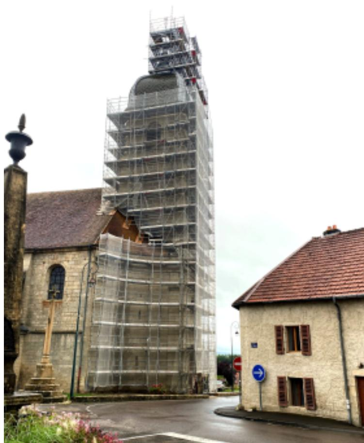
Ces travaux portent sur la reprise d'éléments de charpente, de couverture et de zinguerie (remplacement des gouttières et descentes défectueuses des eaux pluviales, remplacements des tuiles abîmées...).
